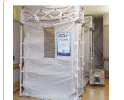
レッドゾーンとグリーンゾーンとの境に簡易陰圧装置(空気感染隔離ユニット)を設置し、イエローゾーンとする。
